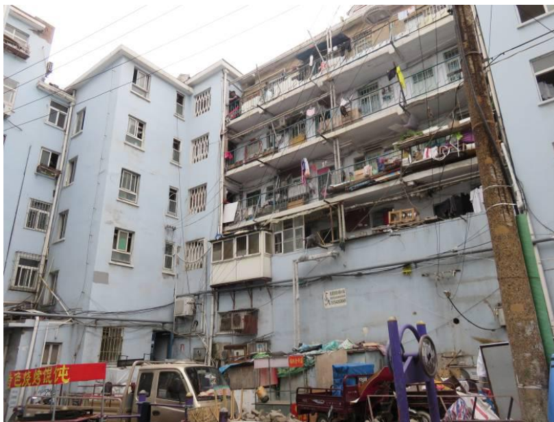
图 1-1 台东一路 32 号住宅楼外立面照片
