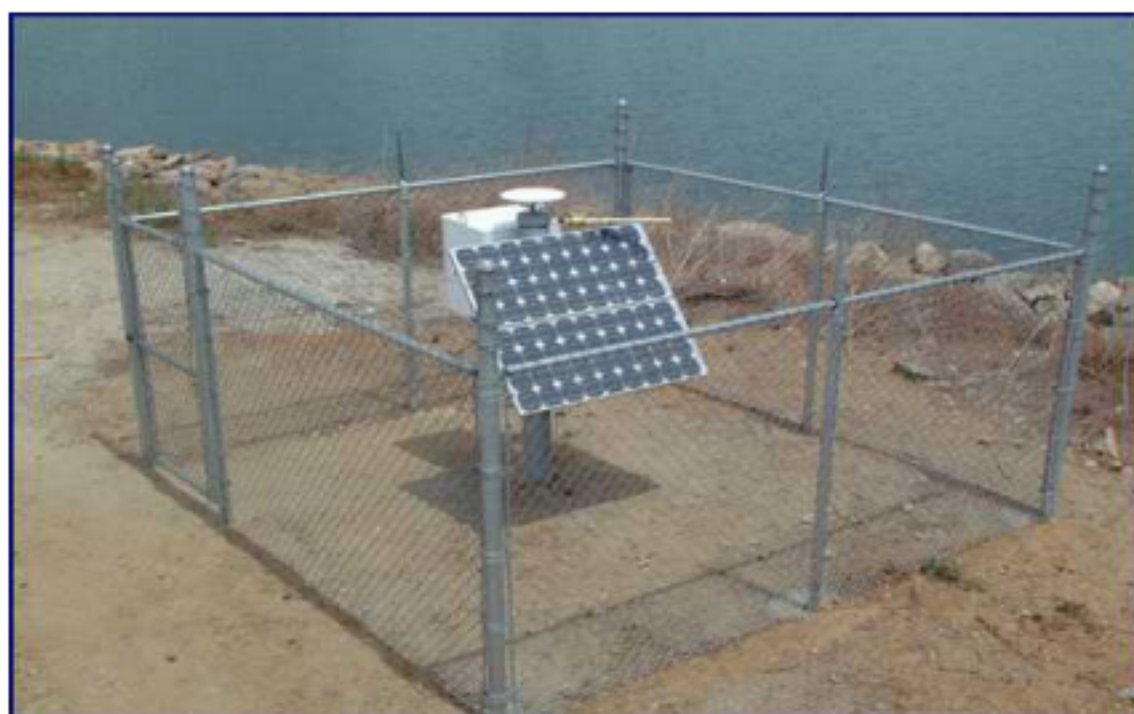
Trimble Zephyr Geodetic 天线安装在观测墩上及太阳能电源系统实例图
